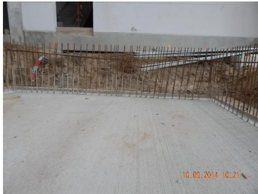
Betonierte Bodenplatte mit Wandanschlussbewehrung und Contaflexactive- Fugenblech
