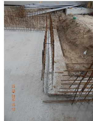
Betonierte Bodenplatte mit Wandanschlussbewehrung und Contaflexactive- Fugenblech
