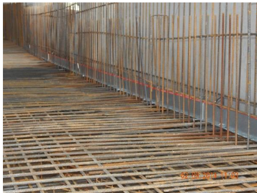
Fugenblech in horizontaler Arbeitsfuge – Befestigung mit Haltebügeln in Wandmitte
