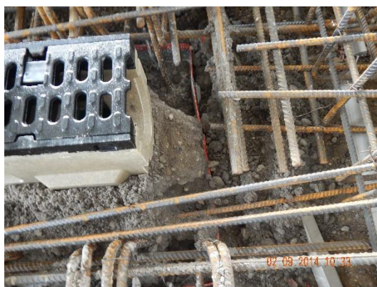
Verunreinigungen am Fugenblech / wurden von Fa. Kellner entfernt
