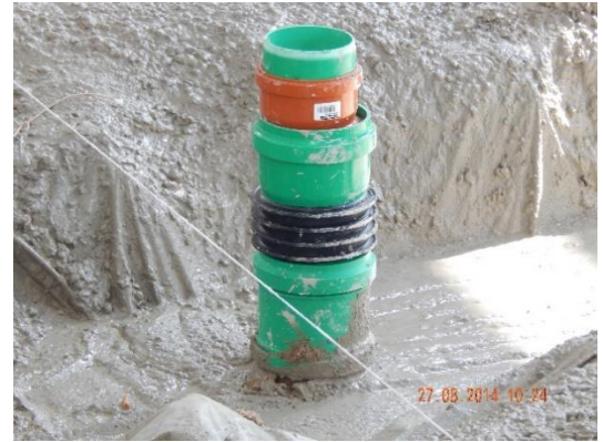
Rohrdurchführung mit „Kraso“- Dichtmanschette
