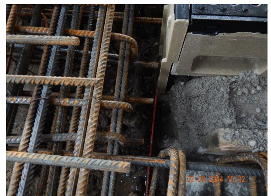
Verunreinigungen am Fugenblech / wurden von Fa. Kellner entfernt
