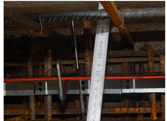
Fugenblech in horizontaler Arbeitsfuge – Befestigung mit Haltebügeln in Wandmitte
